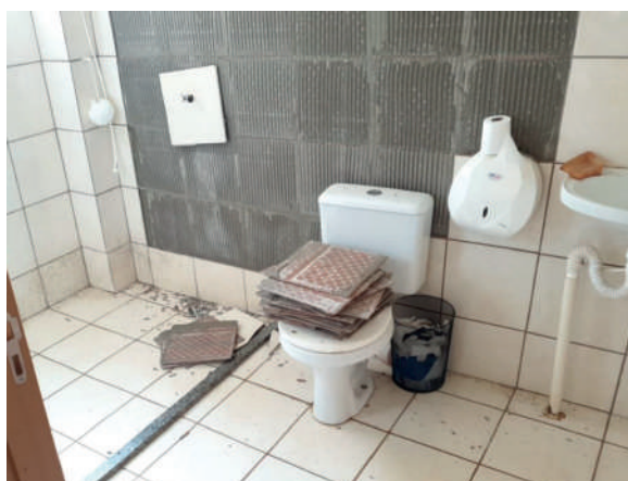
Manifestação patológica decorrente de falha construtiva
